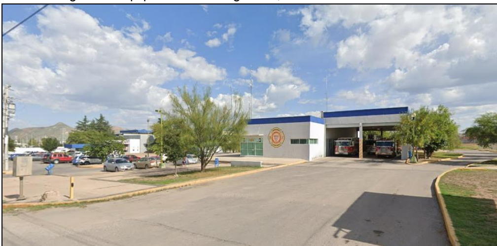
Imagen 29. Equipamiento de seguridad, Estación de Bomberos No. 3.
