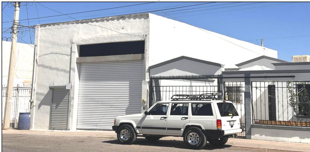
Imagen 61. Aprovechamiento de bodega en el Vista del predio de aplicación.
